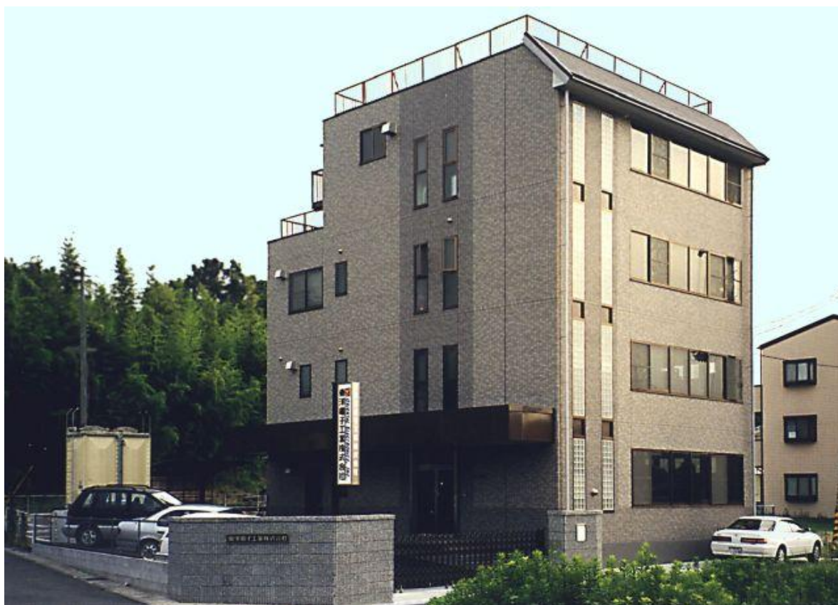
東洋電子工業株式会社 本社ビル
